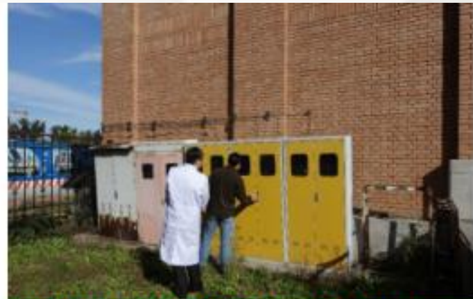
将危险气体移到室外，无遮阳遮雨、柜子不上锁。有7瓶氢气和一氧化碳
